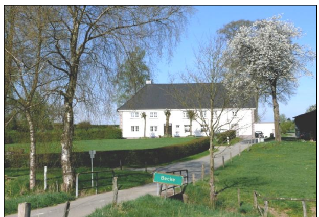
F Becke; Wohnhaus des Diedrich Wilhelm Cramer, 18. Jh.
